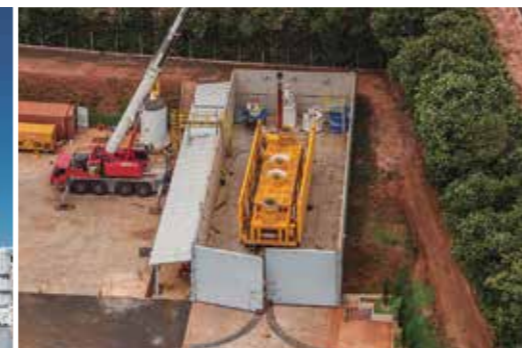
unidade de teste hidrostático área 360 m 2 (30 x 12 x 5 H) pressão de teste 12.000 psi hydrostatic test unit area 360 m 2 (30 x 12 x 5 H) test pression 12.000 psi
